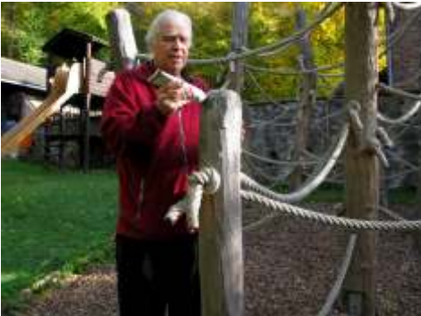
Freddy streicht die Stämme der Kletteranlage mit Baumwachs
